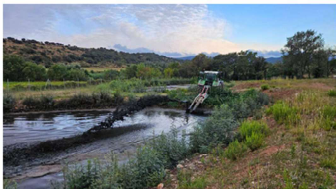
Photos du curage des boues de la Station d'épuration de Le Bosc – Mas Lavayre
