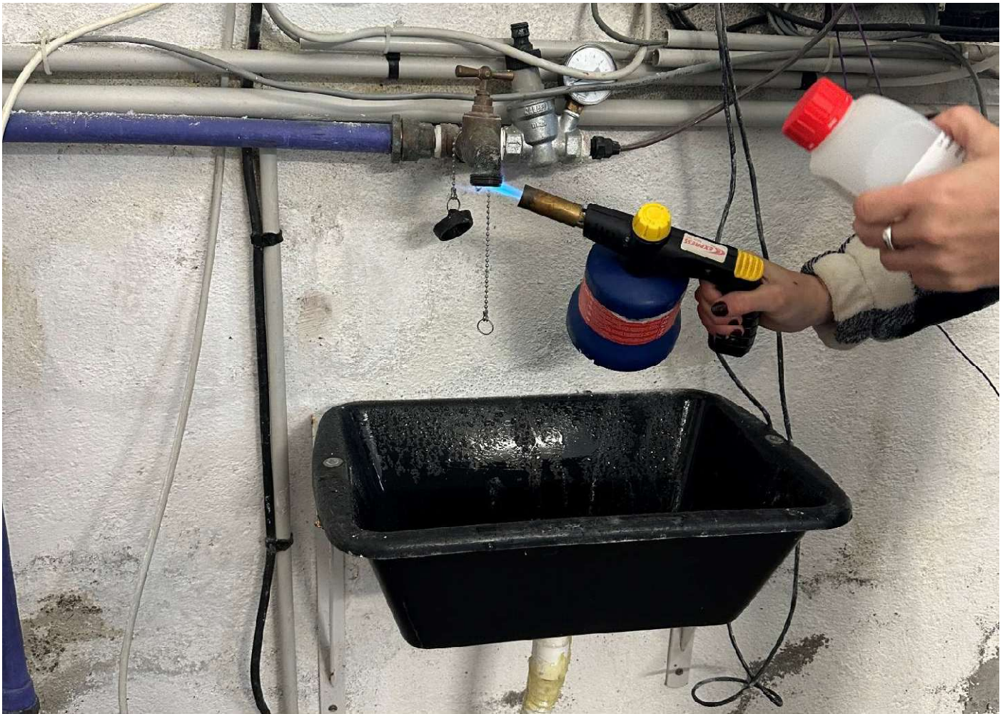
Désinfection par la chaleur pour éliminer toute contamination microbologique sur le robinet de prélèvement
