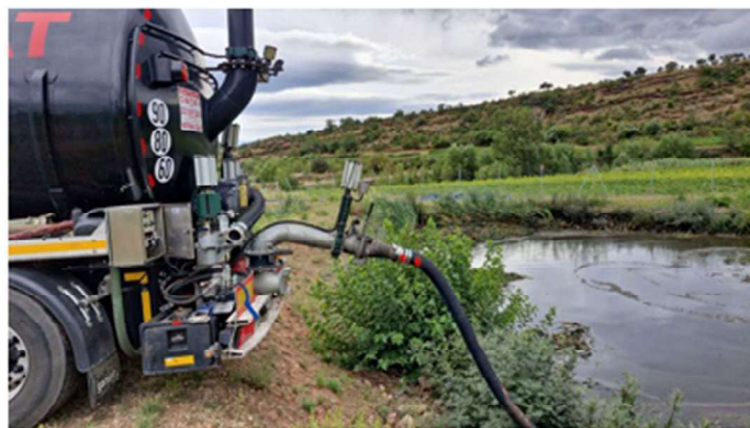
Photos du curage des boues de la Station d'épuration de Le Bosc – Mas Lavayre
